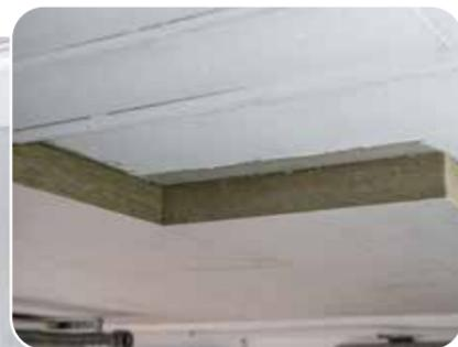
**TIPP:** ACHTEN SIE AUF DIE BRANDSCHUTZKASSE DER PLATTEN – BEI KELLERRÄUMEN MIT TECHNIKEINSTRUMENTEN IST NICHT BRENNBARES MATERIAL (Z. B. MINERALWOLLE) DIE BESSERE WAHL.
