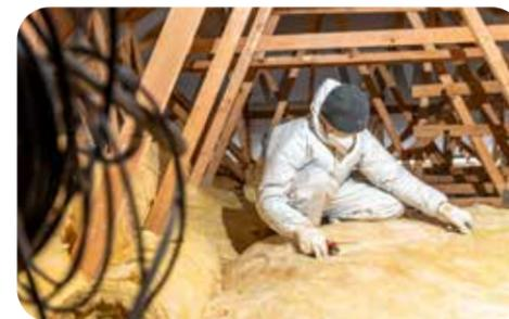
Dämmmaterial wird direkt auf die Decke des obersten Geschosses gelegt. Diese Methode ist einfach, kostengünstig und für ungenutzte Dachböden geeignet.
