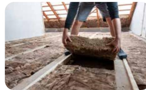
Das Dämmmaterial wird in die Zwischenräume der Decke eingebracht, was besonders bei Holzbalkendecken effektiv ist. Die Zwischendeckendämmung bietet den Vorteil, weniger Raum einzunehmen, da das Dämmmaterial zwischen den Sparren platziert wird. Dafür müssen die Sparren stabil und ausreichend groß sein. Da Sparren meist nur 10-16 cm dick sind, müssen sie oft durch „Aufdoppeln“ verstärkt werden, um die erforderliche Dämmstärke von 20-24 cm zu erreichen.
