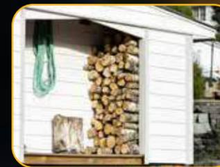
Wer lieber selbst baut, kann sich mit ein paar imprägnierten Holzlatten einen einfachen Unterstand konstruieren. Für das Dach eignen sich wetterfeste Materialien wie Bitumenwellplatten, Blech oder stabile Folien. Egal ob gekauft oder selbst gebaut – Hauptsache, das Holz bleibt trocken und kann gut atmen.
