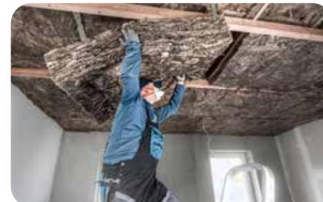
Eine Möglichkeit zur Dämmung der obersten Geschossdecke ist die Unterdeckendämmung, bei welcher der Dämmstoff unter der Decke angebracht wird. Dies verringert jedoch die Raumhöhe darunter und erfordert bei unbewohnten Dachböden eine Dampfsperre nach oben.
